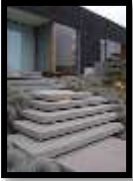
شكل (9) سلم خارجي
